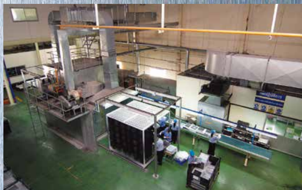
耐熱塗装プラント
