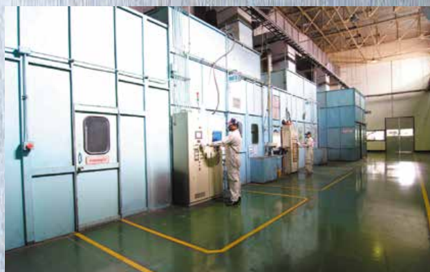
静電塗装プラント
